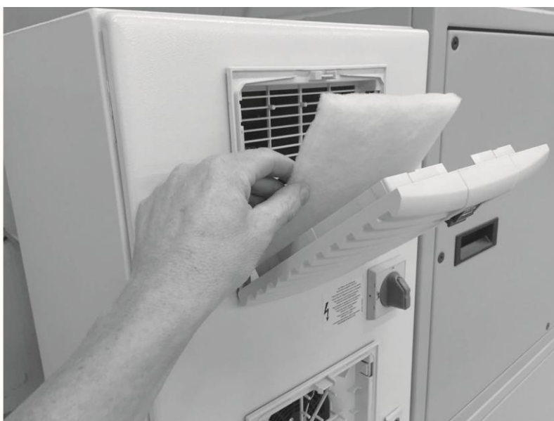
Fig. 39: Sostituzione filtro e quadro elettrico
